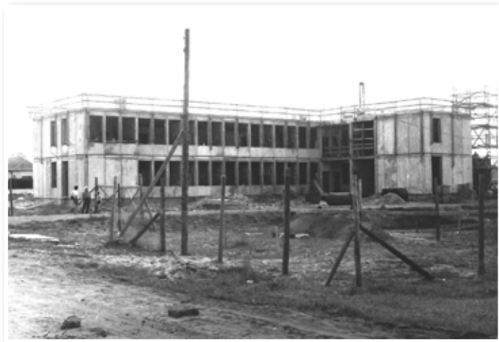
Épül az óvoda (1974)
