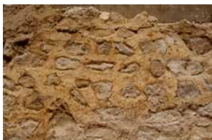
38. kép: Az erőd fal falazási módja. A szabálytalanul rakott kövek között a fugákat habarccsal kenték ki
